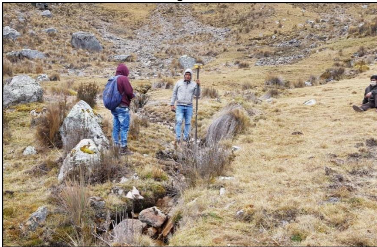
En la imagen se observa al personal de topografía, realizando los trabajos de levantamiento de puntos de captación y la línea de conducción de la localidad de Totorabamba.
