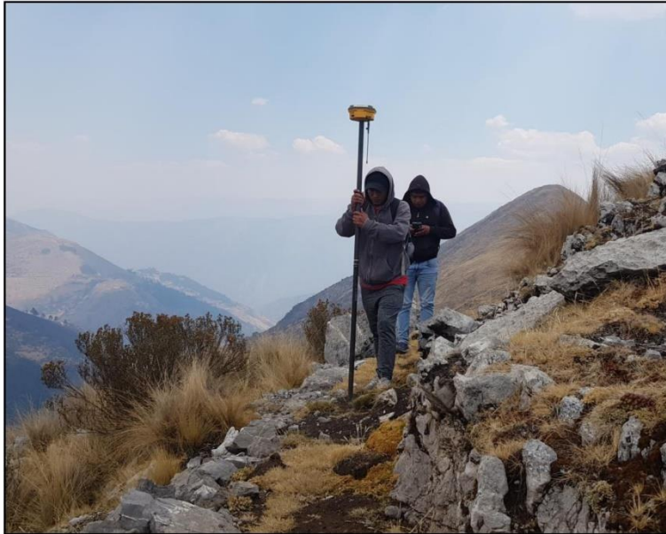
En la imagen se observa al personal de topografía, realizando los trabajos de levantamiento de puntos en la línea de conducción de la localidad de Challhuani.
