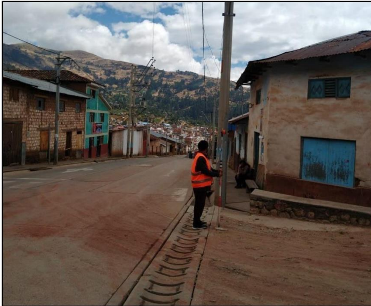
En la imagen se observa al personal de topografía, realizando el levantamiento de puntos detallados de la ubicación de viviendas, en la localidad de Vista Alegre.
