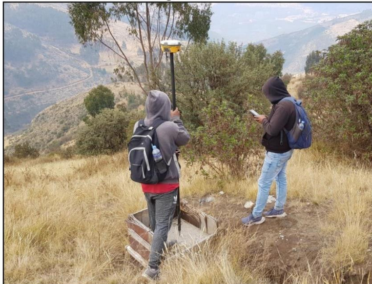
En la imagen se observa la línea de conducción existente de la localidad de Challhuani, donde se realizó el levantamiento topográfico.
