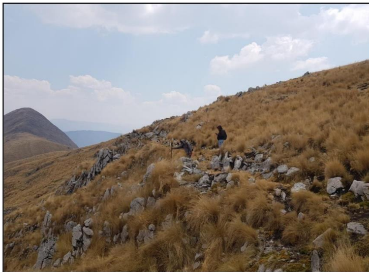
En la imagen se observa al personal de topografía, realizando los trabajos de levantamiento de puntos en la línea de conducción de la localidad de Challhuani.
