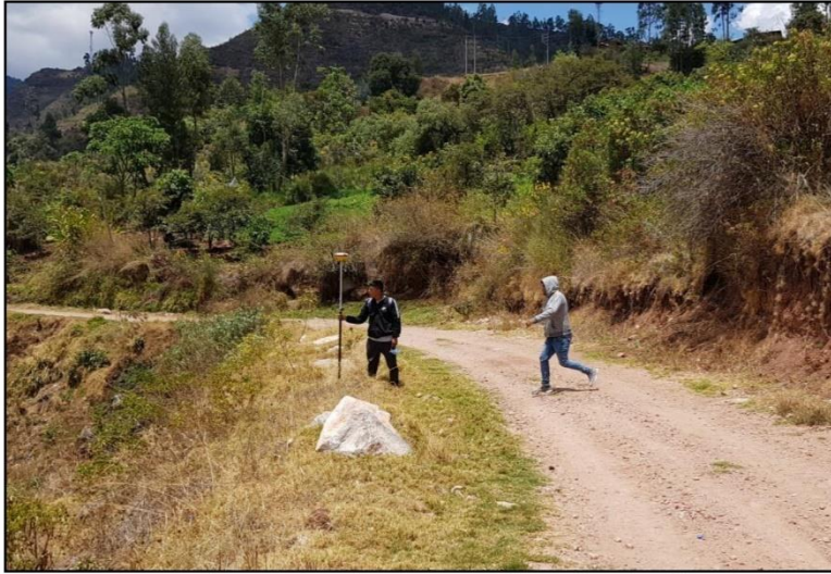
En la imagen se observa al personal técnico de topografía, realizando el levantamiento topográfico en el sector del distrito de chincheros.
