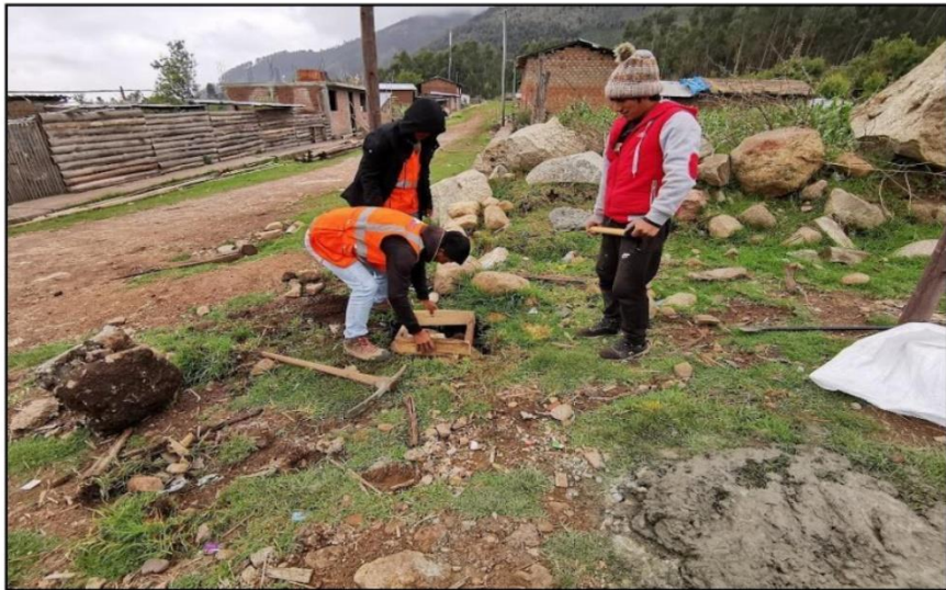
En la imagen se observa al personal técnico realizando el correspondiente monumentado para los puntos geodésicos, en bloque de concreto de 40x40x60.
