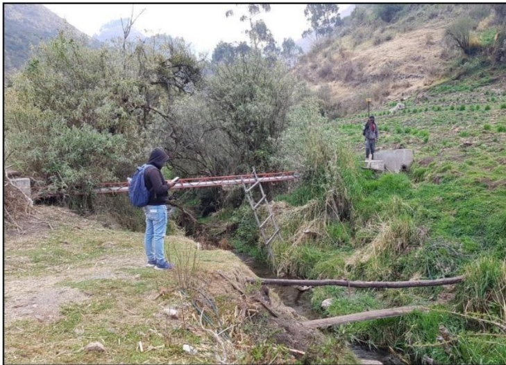
En la imagen se observa al personal de topografía, realizando los trabajos de levantamiento de puntos del pase aéreo de la línea de conducción de la localidad d de Challhuani.
