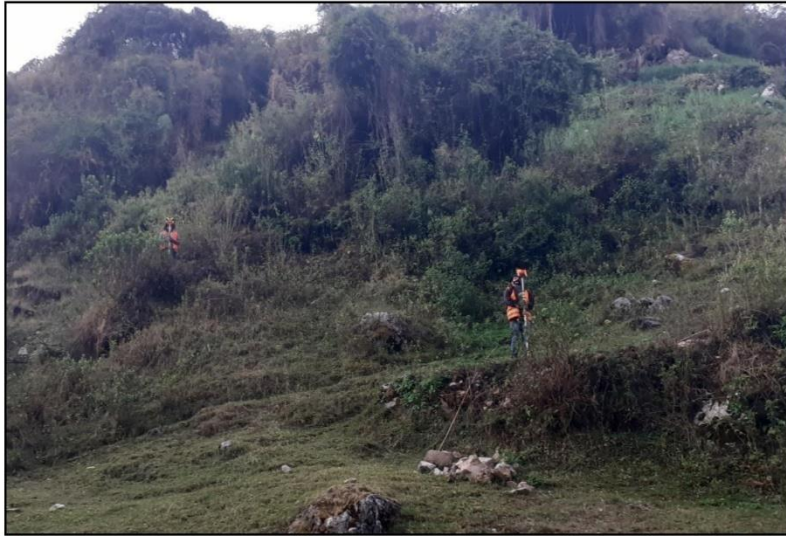
En la imagen se observa la cuadrilla de levantamiento topográfico, realizando los trabajos de levantamiento de puntos en la línea de conducción hasta el reservorio de la localidad de Muñapucro.
