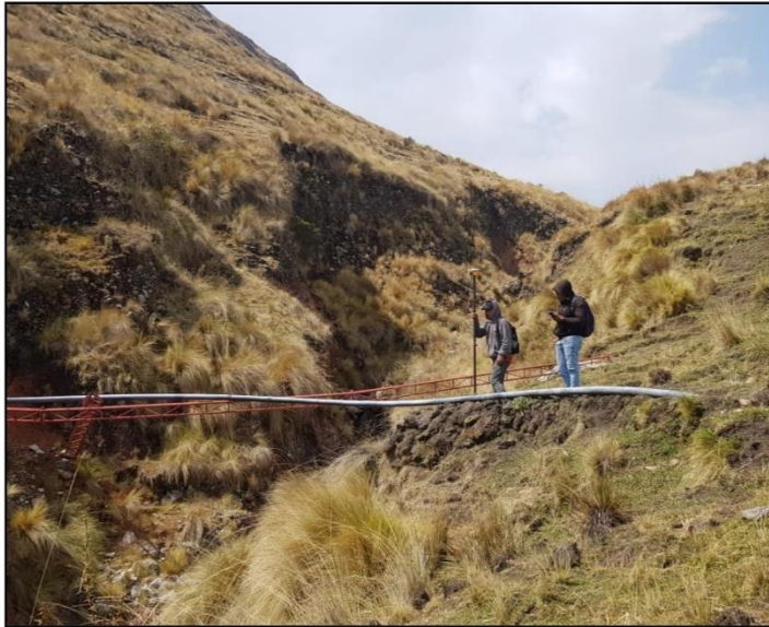
En la imagen el pase aéreo de la línea de conducción de la localidad de Challhuani, donde se continua con el levantamiento topográfico.
