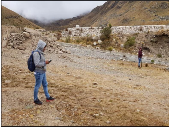
En la imagen se observa la cuadrilla de levantamiento topográfico, realizando el levantamiento de la línea de conducción de la localidad de Totorabamba.
