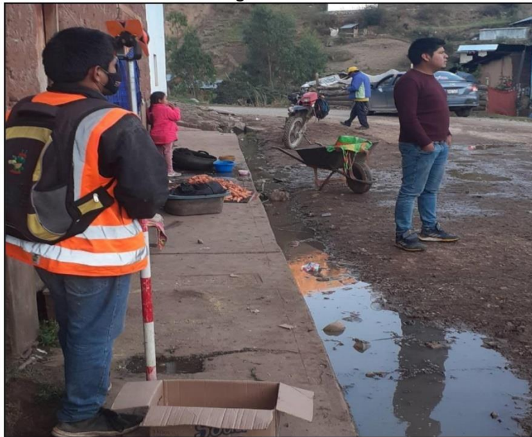
En la imagen se observa al personal de topografía, realizando los trabajos de levantamiento de puntos de la localidad de Muñapucro.
