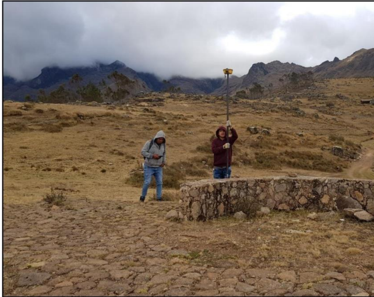
En la imagen se observa la cuadrilla de levantamiento topográfico, realizando los trabajos de levantamiento de puntos en la línea de conducción hasta el reservorio de la localidad de Muñapucro.
