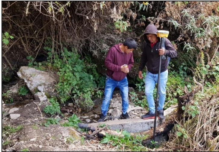
En la imagen se observa la cuadrilla de levantamiento topográfico con GPS diferencial, realizando los trabajos de levantamiento de puntos en la línea de conducción hasta el reservorio de la localidad de Muñapucro.
