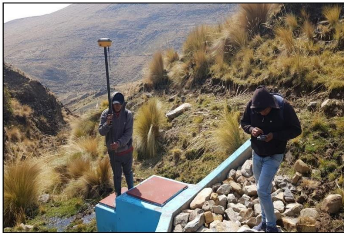
En la imagen se observa las captaciones existentes de la localidad de Challhuani, donde se continua con el levantamiento topográfico
