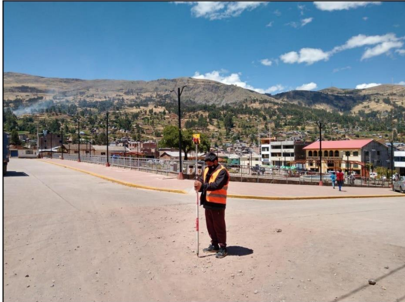
Vista panorámica donde se observa al personal técnico de topografía, realizando el levantamiento de puntos detallados de la pista, vereda y ubicación de viviendas de la localidad de Uripa.
