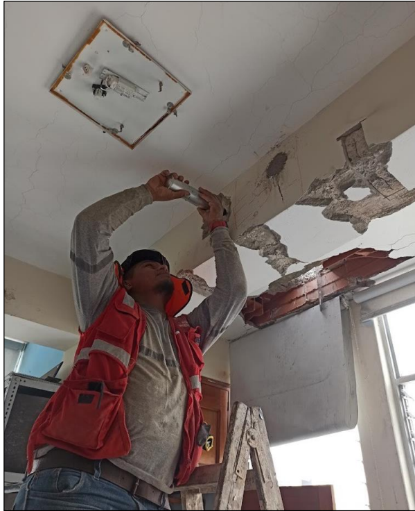
Foto 1. Extracción de testigos diamantinos.
