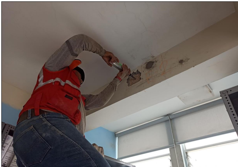
Foto 4. Aplicación del esclerómetro en viga.
