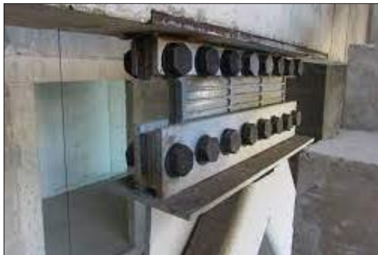
Figura 2. Disipadores de energía SLB y la forma de montaje.
