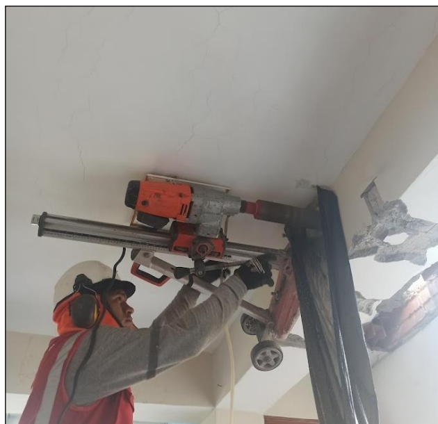
Foto 2. Aplicación de maquina perforadora de testigos en vigas.
